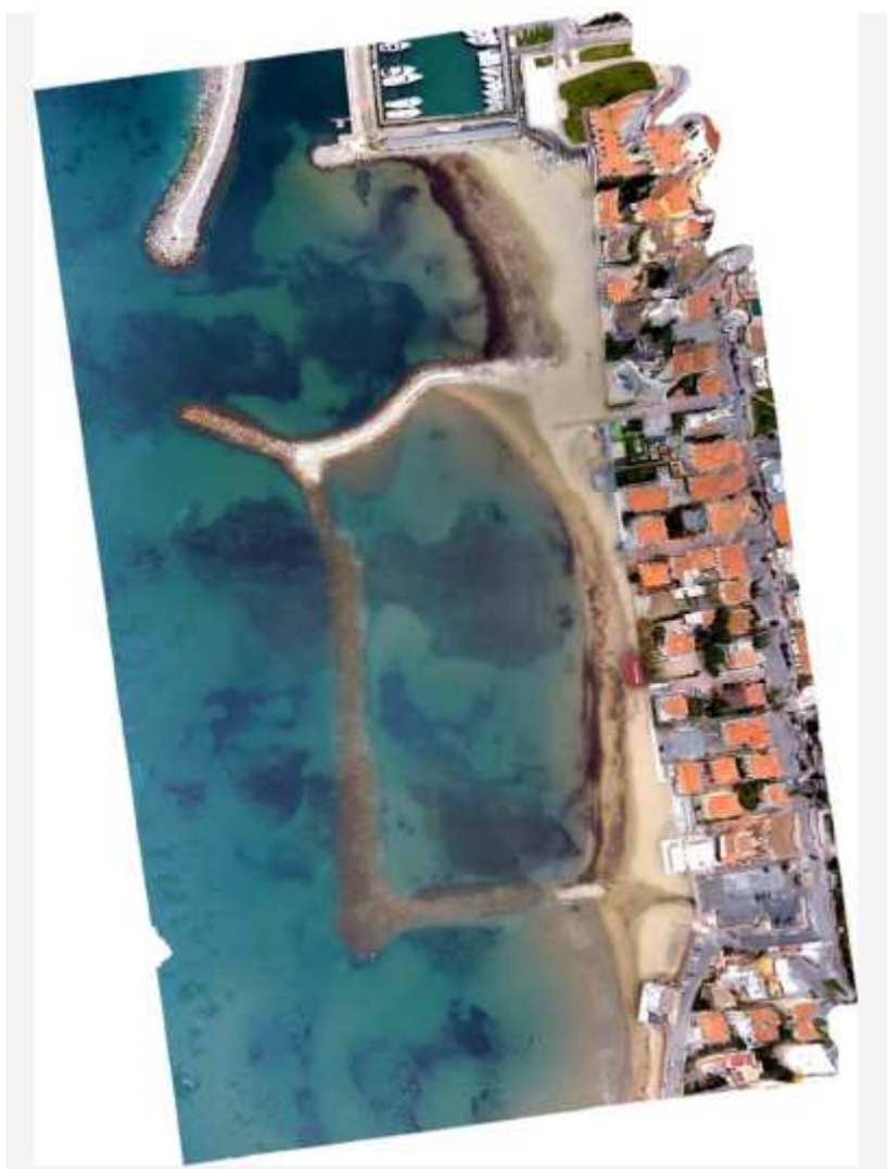
Figura 2 Lato sud del porto
